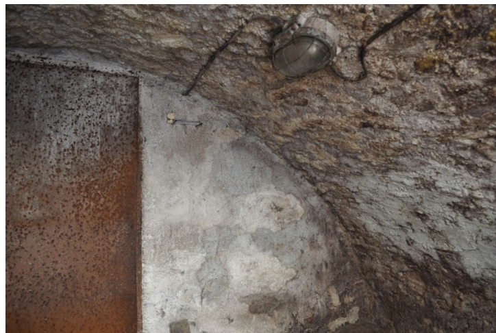
Z pôvodnej stavby sa zachovala iba časť klenby v pivnici
